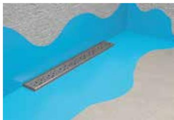
4. Tragen Sie als erstes die Grundierlösung (Primer) auf den getrockneten Estrichbereich auf und lassen diesen ebenfalls trocknen. Tragen Sie danach die erste dünne Schicht der Flüssigdichtfolie auf die Primerschicht auf (z.B. das Wiper® Dichtungsset, zusätzlich bestellbar). Beachten Sie hierbei, dass Sie noch Platz für eine weitere Schicht der Folie sowie für die Dichtmanschette benötigen.
