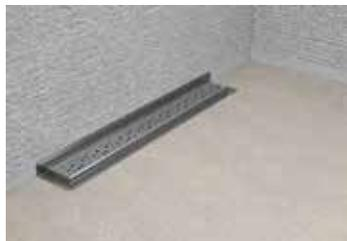
3. Füllen Sie den Bereich unter und rund um die Duschrinne mit flüssigem Estrich auf, bis zur Oberkante des Isolierflansches und lassen diesen komplett trocknen.
