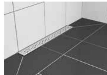
7. Sobald die Flüssigfolie gemäß Herstellerinformation vollständig durchgetrocknet ist, können Sie den Duschbereich mit dem gewählten Bodenbelag verlegen (z.B. keramische Fliesen, Feinsteinzeug oder Granit). Dichten Sie zuletzt noch den Spalt zwischen Fliesen und Rinnenkörper sowie Fliesen und Wand mit einem entsprechendem Sanitärsilikon ab.
