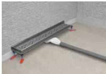
2. Befestigen Sie den mitgelieferten Siphon sowie die höhenverstellbaren Standfüße am Duschrinnenkörper. Anschließend schließen Sie den Siphon an das Abwassersystem an. Justieren Sie die Einbauhöhe der Duschrinne mithilfe der Höhenverstellung an den Standfüßen. Der obere Rand des Duschrinnenrahmens sollte sich ca. 1mm unterhalb der Fußbodenoberfläche befinden.
