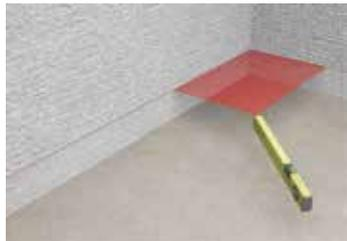
1. Zunächst bestimmen Sie die Höhe des fertigen Duschbodens mitsamt Bodenbelag und markieren den Bereich an der Wand, in dem die Duschrinne montiert werden soll. Bedenken Sie dabei ein entsprechendes Gefälle des Duschbereichs zum Ablauf hin. Wir empfehlen ein Gefälle von ca. 2%.
