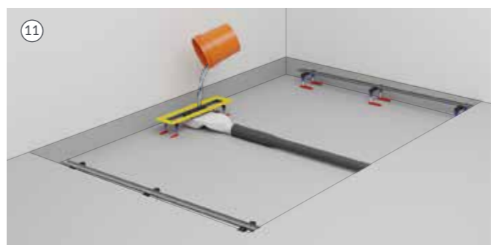
11. Die Rinne aus der Basis entfernen. Den Abfluss an die Installation anschließen und die Dichtheitsprüfung durchführen.
