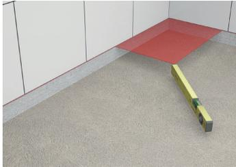
1. Zunächst bestimmen Sie die Höhe des fertigen Duschbodens mitsamt Bodenbelag und markieren den Bereich an der Wand, in dem die Duschrinne montiert werden soll. Bedenken Sie dabei ein entsprechendes Gefälle des Duschbereiches zum Ablauf hin. Wir empfehlen ein Gefälle von ca. 2%.
