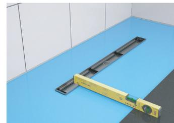
7. Stellen Sie nun mit Hilfe des beigefügten Schraubensets die gewünschte Höhe des Rahmens in Abhängigkeit der Stärke Ihres Bodenbelags ein. Beachten Sie dabei, dass der obere Rand des Duschrinnenrahmens sich ca. 1mm unterhalb der Fußbodenoberfläche befinden sollte.
