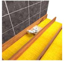
Schließen Sie ein Standard DN50 Rohr an den Siphon an. Wenn Sie es an der korrekten Position fixiert haben, verwenden Sie nun einen Silikon-Dichtstoff, um das Abflussrohr mit dem Abwassersystem zu verbinden. Füllen Sie den Siphon von oben testweise mit Wasser, um die Funktionalität zu überprüfen.
